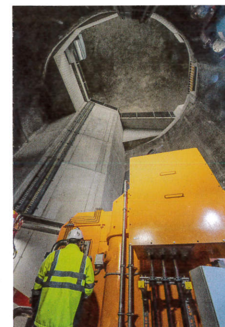
La centrale ha un accesso stradale dimensionato per i grossi camion che hanno trasportato il generatore e la turbina. Il carro-ponte da 40 ton è servito al carico-scarico e per posare generatore e turbina in fondo al pozzo.
