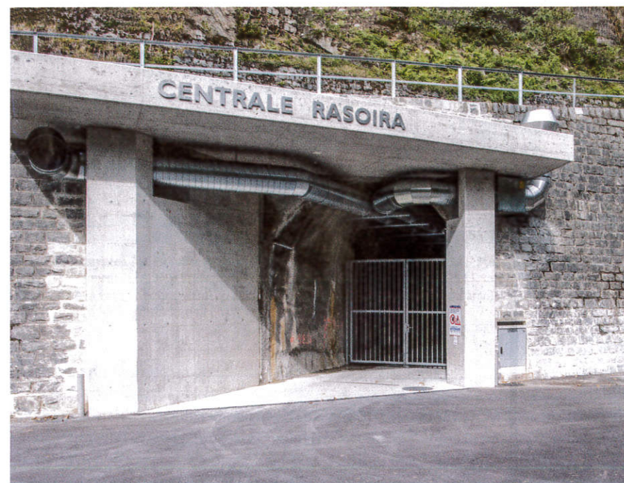
Qui sopra l'entrata della galleria che porta alla minicentrale Rasoira costruita all'interno della montagna e che si trova accanto al lago di Malvaglia.
